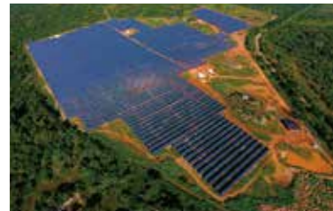
スリランカ 12MW
