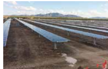
オーストラリア 128MW Clare solar farm
